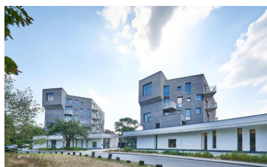
Archiducs – AR : Pierre Blondel Architectes
