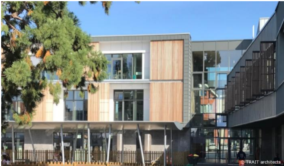
Figure 1 : Les protections solaires sont les premiers remparts aux surchauffes dans les bâtiments. Ce projet illustre différents systèmes architecturaux pour se protéger du soleil : auvents, volets coulissants, éléments fixes, ouvrants pliants et végétation.
